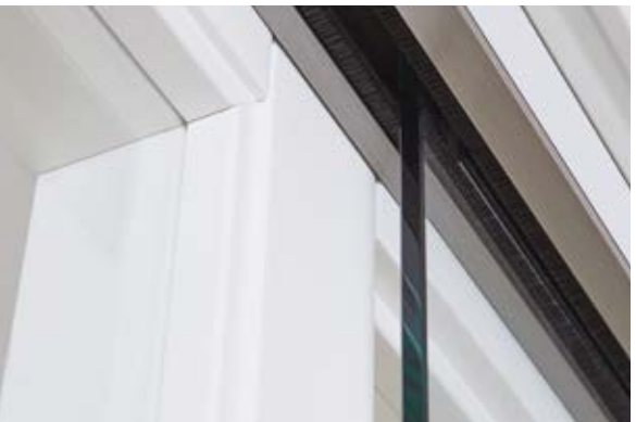
Befestigung einer Ganzglastür im Schiebetürbeschlag LINE
