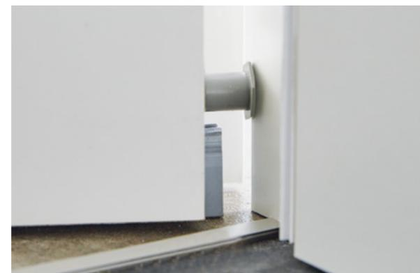
Auslöser für automatisch absenkende Bodendichtung
